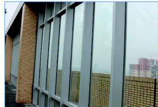
頂樓除加裝欄杆，並於欄杆間加設強化玻璃
