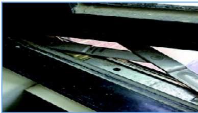
外推式窗戶裝設門止器、安全鎖，限制窗戶開啟寬度小於 10 公分
