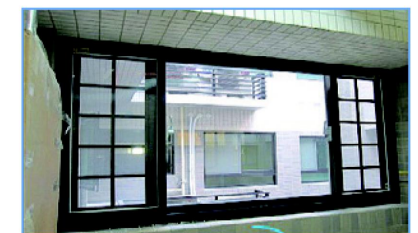
推拉式窗戶加裝防墜格柵，且隔柵最大拉寬不超過 10 公分
