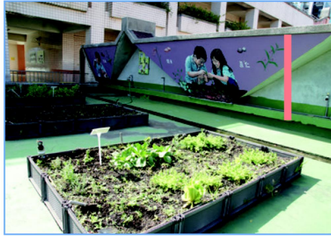
頂樓女兒牆高度達 190 公分，可設置屋頂農場，除發揮降溫功能外，另兼具休閒、教育、生態、景觀營造等多重效益
