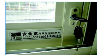
窗戶加裝兒童安全鎖，限制窗戶開啟寬度不超過 10 公分
