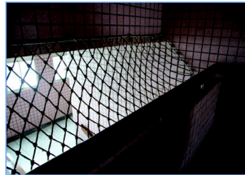
在樓梯轉角處加裝安全防墜網
