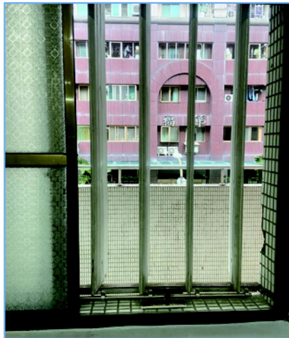
為強化防墜，於水平式推拉窗戶之外牆開口部加裝直式百葉窗
