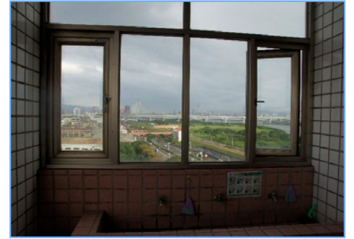
在走廊邊間的窗戶為外推式窗戶，加裝開啟停止之裝置，限制窗戶開啟之寬度為 10 公分
