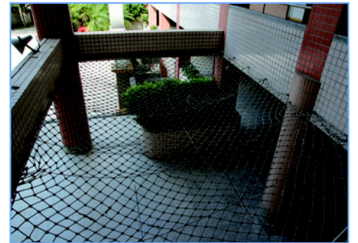
在天井處加裝安全防墜網
